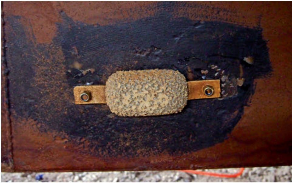
Veneeseen asennettu kymmenen vuotta sitten magnesiumanodit joissa näkyy hyvin kulumista, eli suojaus on toiminut.
